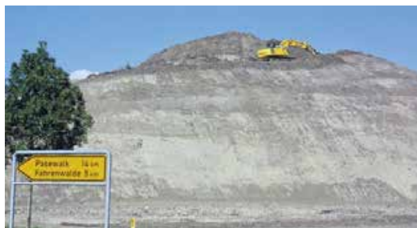
Seit Mitte September ruhen die Arbeiten wieder am künftigen Aussichtspunkt von Brüssow.
