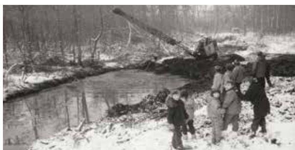
Abb. (338) 1989-90 Winter Kanalbau im Park
