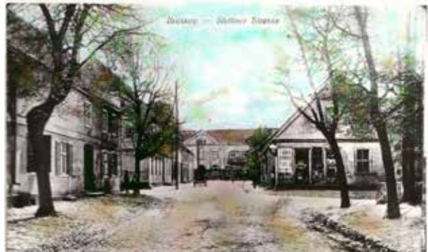
Abb. (138) 1935 Stettiner Straße, Obere Stettiner Straße, links Bäckerei Wenthin, Mitte der neue Schwan, rechts Kaufmann Tieke und Uhrmacher Batzloff.
