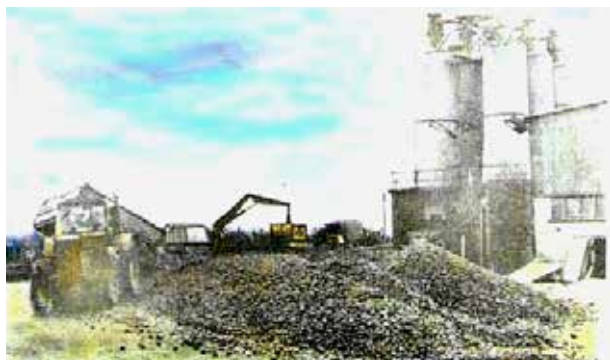
Abb. (284) Umbau des Trockenwerkes zur Getreidetrocknung
