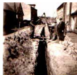
Abb. (231) Wasserleitungsbau in der Rudolf Breitscheidstraße
