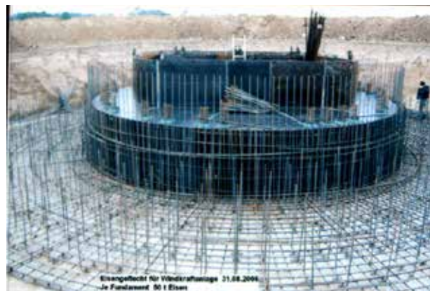
Abb. (372) Bildtext: 31.08.2006 Eisengeflecht für Windkraftanlage, Je Fundament 50 t Eisen
