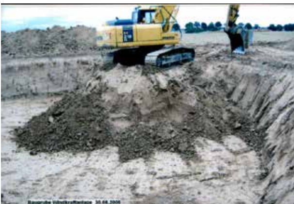
Abb. (371) Bildtext: Baugrube Windkraftanlage 30.08.2006
