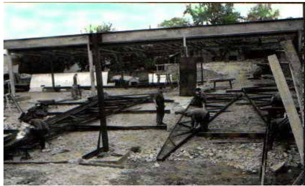
Abb. (293) Rohbau eigene Binderfertigung
