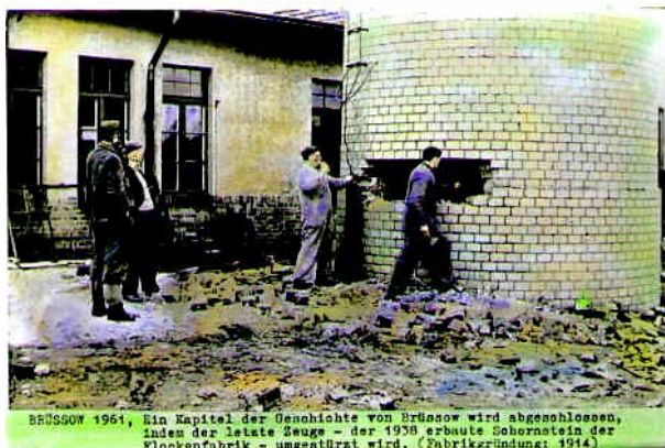
Abb. (256) An der richtigen Stelle wird gestemmt.
