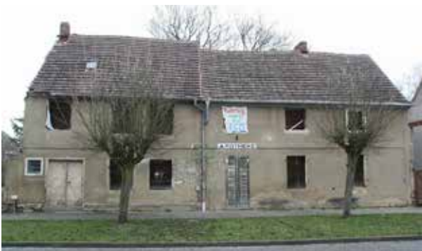
Abb. (411) verwahrlostes Fachwerkhaus der alten Adler Apotheke, Ende 2010 abgerissen
