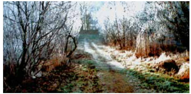
Abb. (244) Der fertige Damm im Winter 1986
