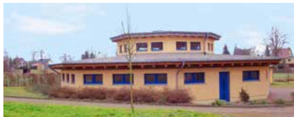
Abb. (363) Mehrzweckgebäude auf dem Zeltplatz
