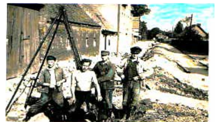
Abb. (234) Wasserleitungsbau in der Prenzlauer Straße
