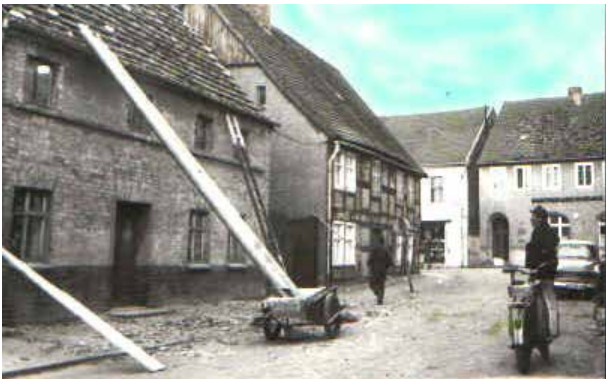
Abb. (290) Als erstes musste Platz geschaffen werden
