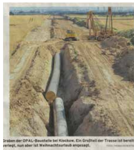
Abb. (407) Bau der Ostsee-Pipeline „Opal“
