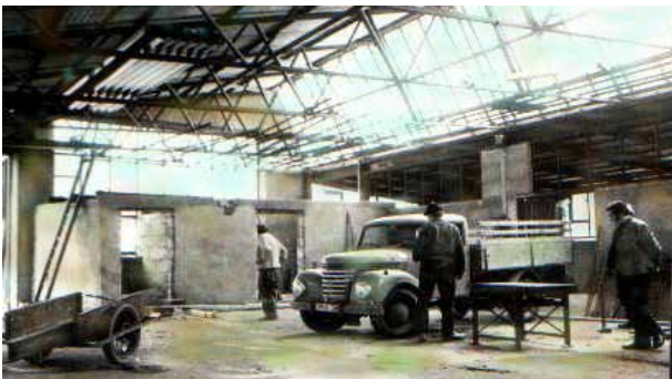
Abb. (294) Halle im Rohbau mit kleinem Framo
