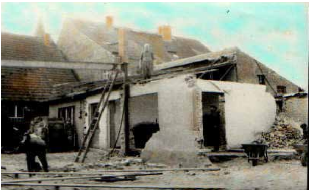
Abb. (292) Abbruch der Sattlerwerkstatt
