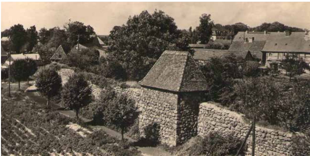
Abb. (109) Stadtmauer um 1955
