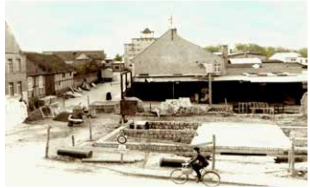
Abb. (326) 1983 Der Bau eines kleinen Lebensmitteladens durch die ZBO
