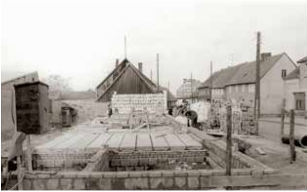
Abb. (325) 1983 Der Bau eines kleinen Lebensmitteladens durch die ZBO
