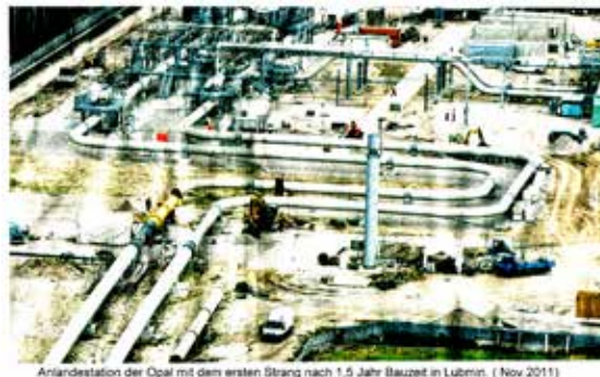
Abb. (406) Bildtext: Anlandestation der Opal mit dem ersten Strang nach 1,5 Jahren Bauzeit in Lubmin (Nov. 2011)
