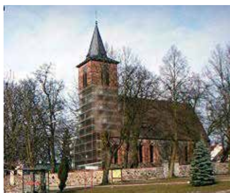
Abb. (357) Einrüstung des Kirchturmes
