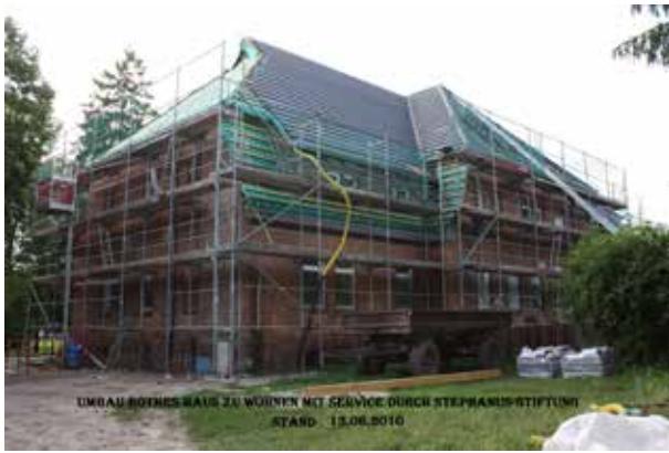
Abb. (402) Umbau „Rothe Haus“, 13.06.2010
