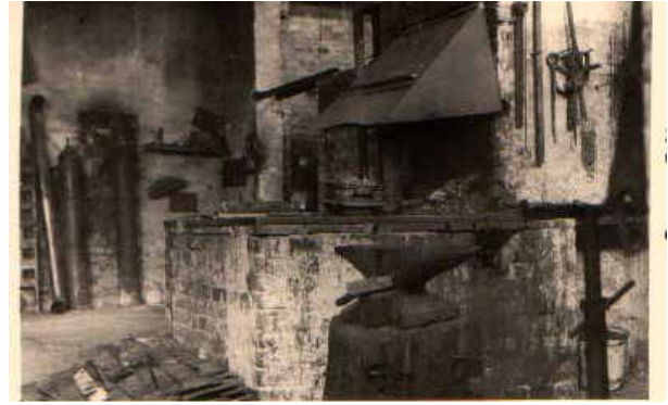
Abb. (297) Die Alte Schmiede im Altbau
