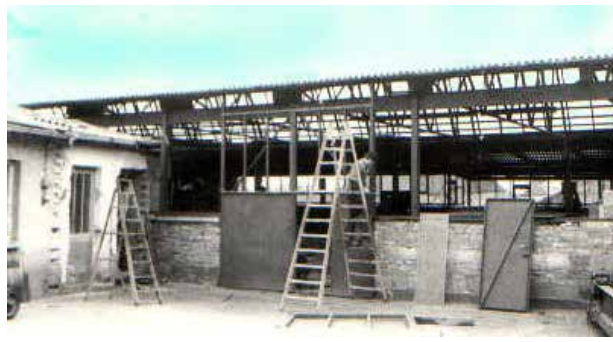
Abb. (295) Von der Hofseite Torbau
