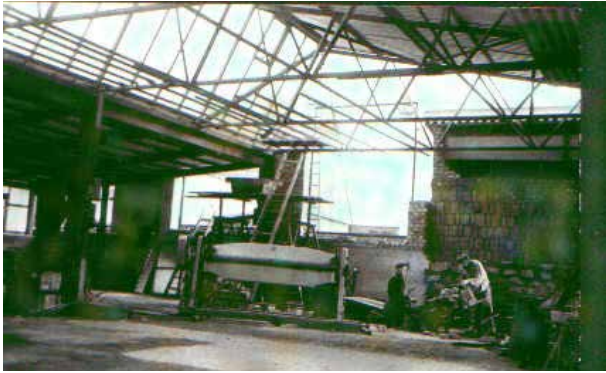
Abb. (296) Trotz Bau, die Fertigung lief weiter
