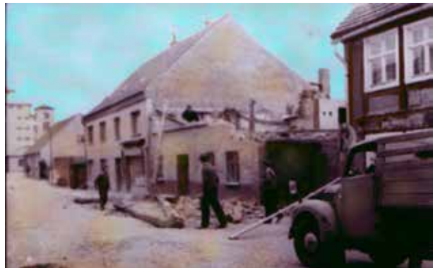
Abb. (291) Abbruch des alten Wohnhauses
