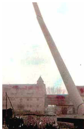
Abb. (258) Fachmännisch wird gearbeitet. Er fällt in die richtige Richtung und zerbricht.
