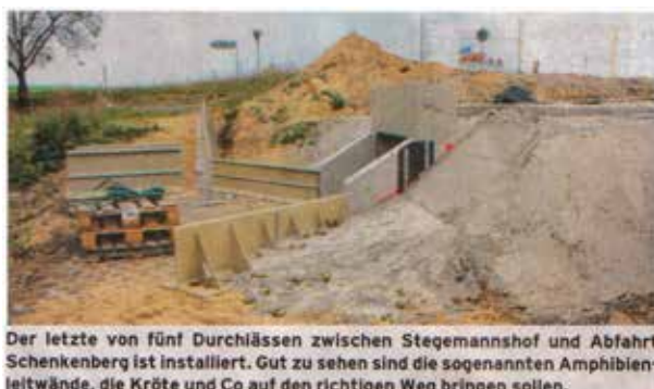
Abb. (413) Baumaßnahmen an der L26
