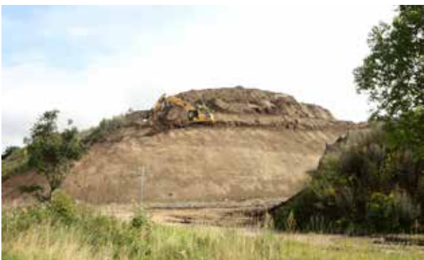
Abb. (427) Arbeiten am „Utkiek“ August 2012
